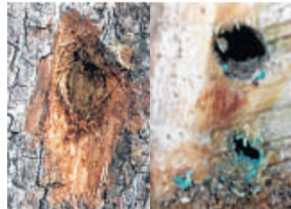
Durch Bohrlöcher wurde die Chemikalie eingeleitet.
